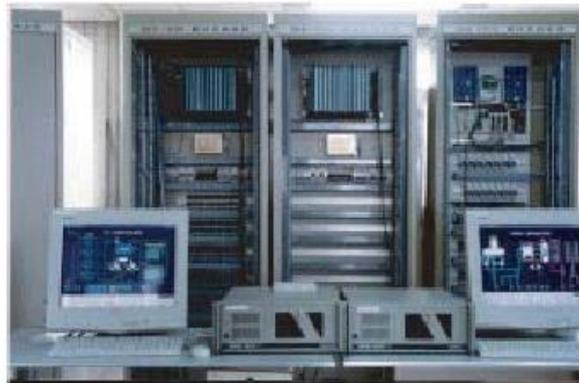
图 1-21 PLC 在水汽集中取样自控系统中的应用
